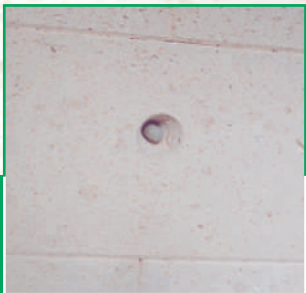
Thermoelement zur Temperatur- erfassung, geschützt eingebaut thermocouple for temperature registration, protected installed
