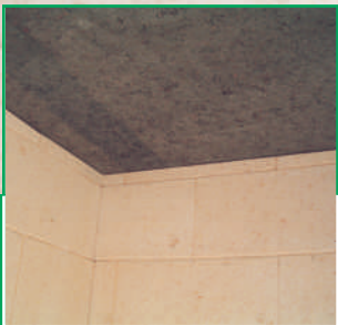
R-SIC-Deckenplatte, kein Befall R-SIC cover sheet, no dust
